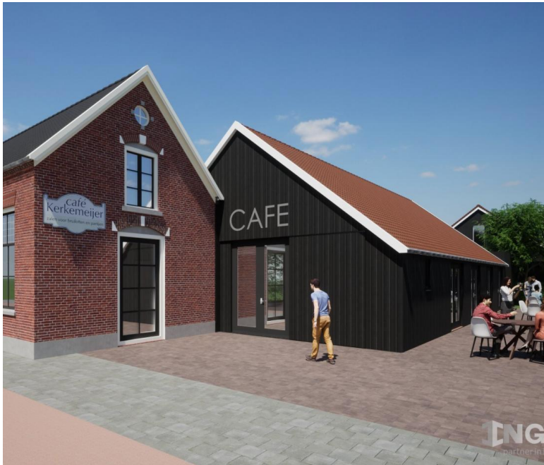
Aanzicht rechtergevel na restauratie en verbouwing
